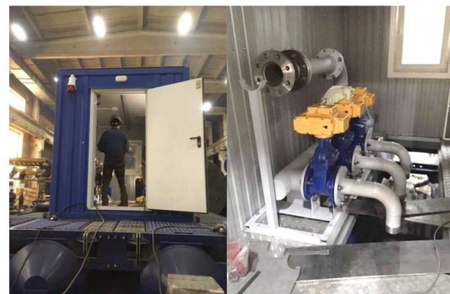
Понтоны и монтаж системы забора воды в контейнере
