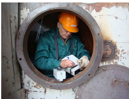
НПЗ АО «АНХК»: контроль качества сварных швов патрубков колонны K-11 магнитным методом прибором КРМ-Ц-К2М на установке ЭЛОУ+АВТ6.
