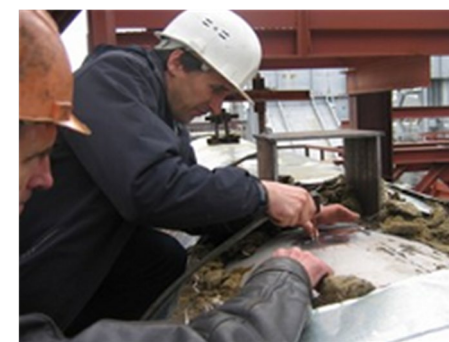
НПЗ АО «АНХК»: Приварка тензодатчиков на трубопроводе установки ЭЛОУ+АВТ6.
