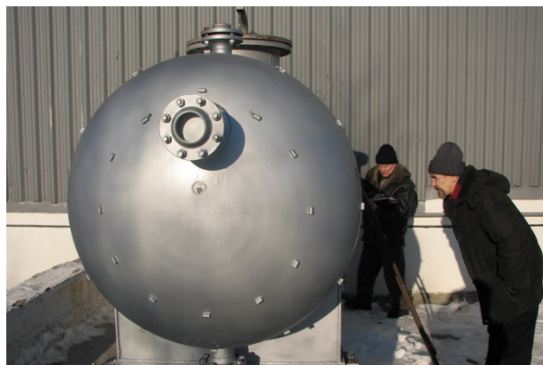
АО «Ачинский НПЗ»: техническое диагностирование и паспортизация емкостей для хранения масла.
