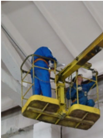
ООО «Востсибуголь»: обследование железобетонных ферм.
