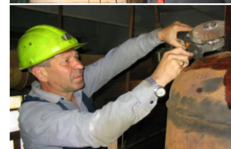
АО «ЦКК» (Филиал АО группы «Илим»), г. Братск: техническое диагностирование оборудования и трубопроводов.
