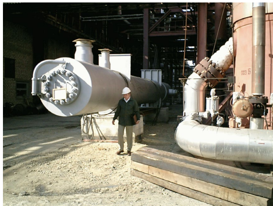
АО «ТольяттиАЗОТ»: подогреватель воды Д = 1600 мм, Р = 31 МПа, Т = 330 °С для утилизации тепла реакции синтеза аммиака из колонны синтеза.
