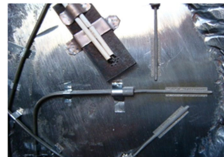
Высокотемпературные тензодатчики на трансферах и патрубках колонны K-11.
