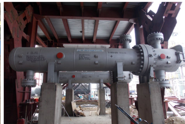
АО «АНХК»: проекты теплообменников Т-102 и Т-101 для нагревания циркуляционного водородсодержащего газа производства дизельного топлива P=10, 25\text{ МПа} , T=455^{\circ}\text{C} . Изготовитель ОАО «Волгограднефтемаш».
