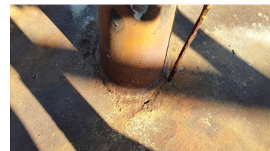
Обследование Резервуара Р-12, АО «АНХК», ПНХ, ц. 39/61, об. 143/144. Выявлен дефект на настиле крыши резервуара.
