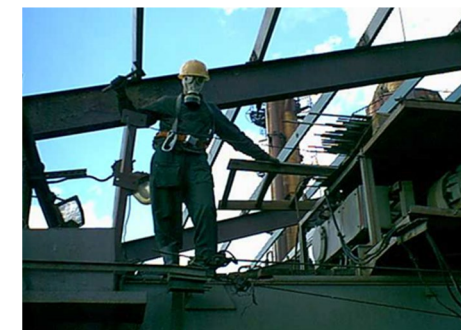
АО «Саянскимпласт»: диагностирование мостового крана. Цех № 30.
