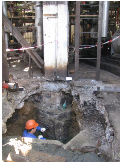
НПЗ АО «АНХК»: обследование фундаментов постаментов.
