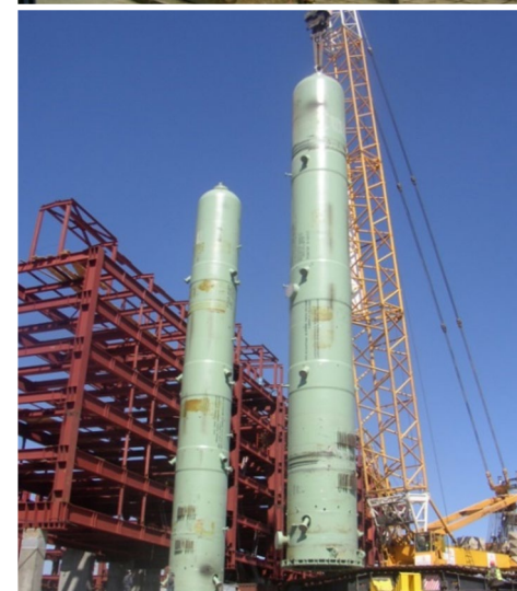
Технические проекты реакторов Р-101 (1,2) установки гидроочистки дизельного топлива АО «АНХК» с последующим авторским надзором за изготовлением на АО «ОМЗ» и АО «Уралхиммаш».
