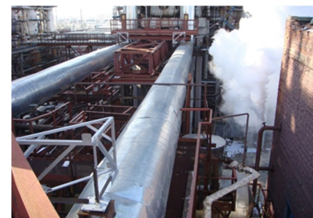
АО «АНХК»: устройство для крепления датчиков положения реперных точек на трансферах колонны K-11.
