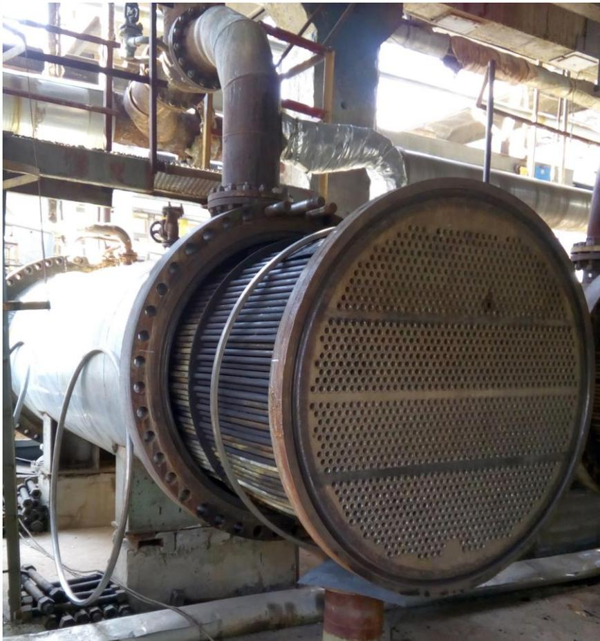
На фото показан распространенный тип кожухотрубного теплообменного аппарата:
